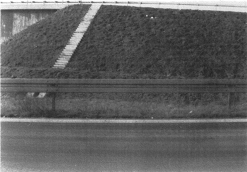
ABB. 2.10 Schutzplankenprofil B
