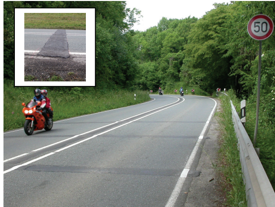
Bild 14: Verkehrssichere Geschwindigkeiten durch Rüttelstreifen
