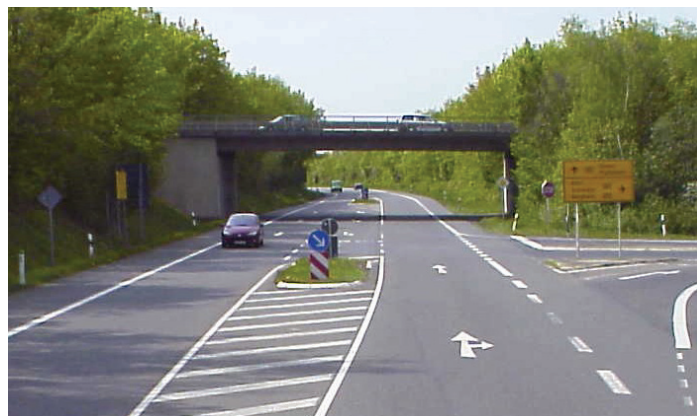
Bild 13: Fahrbahnteiler als Maßnahme gegen Überholmanöver im Knotenpunkt
