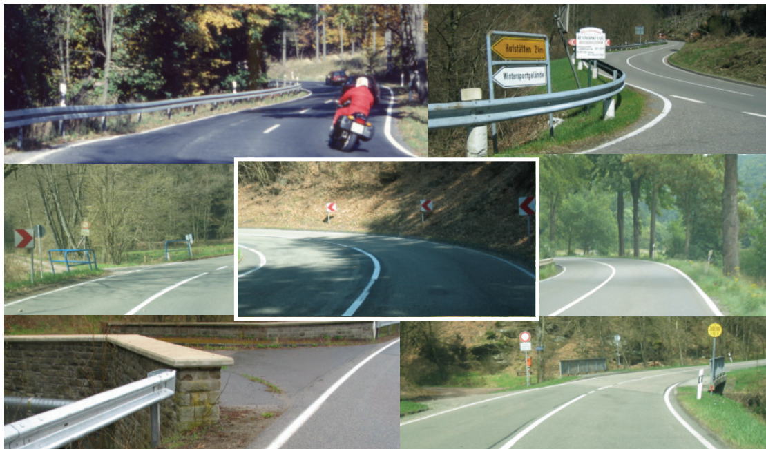
Bild 6: Hindernisse im Seitenraum von Kurven mit hohem Verletzungsrisiko bei Unfällen
